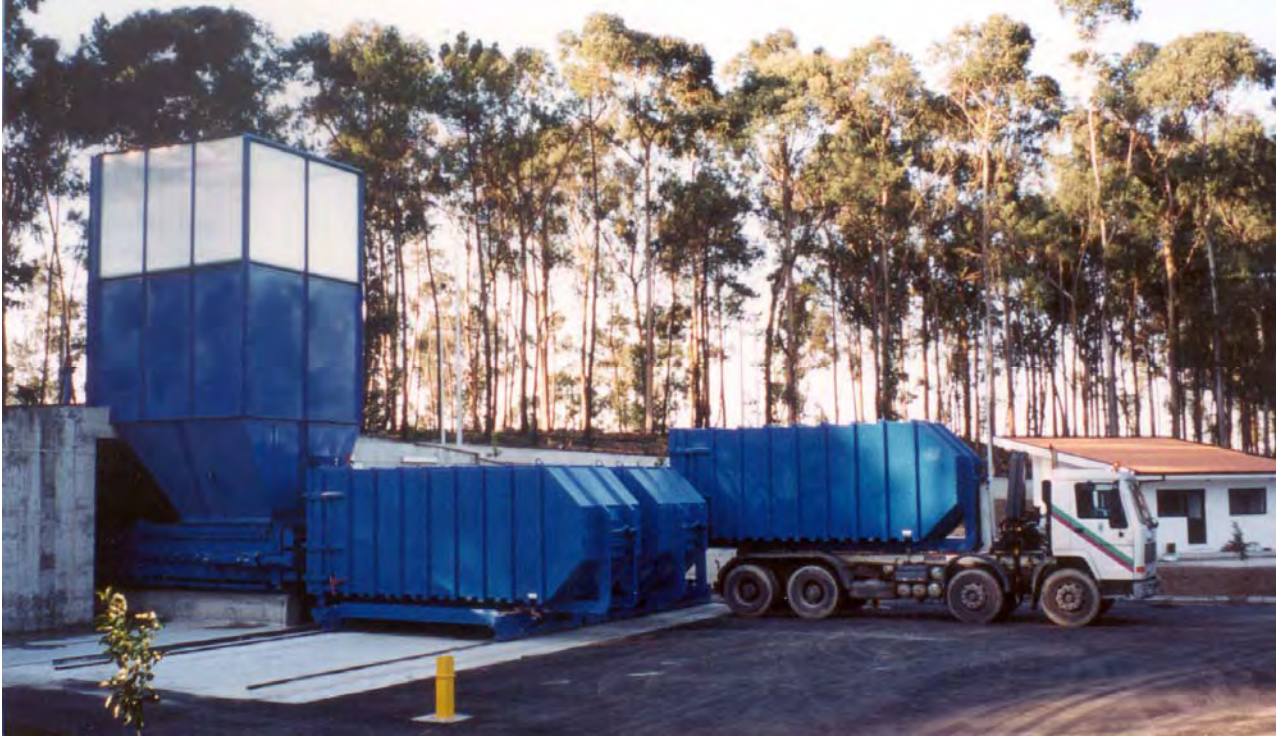
Vista geral da Estação de Transferência de Paredes
