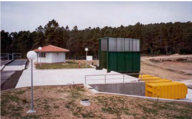
Vista da plataforma de descarga
